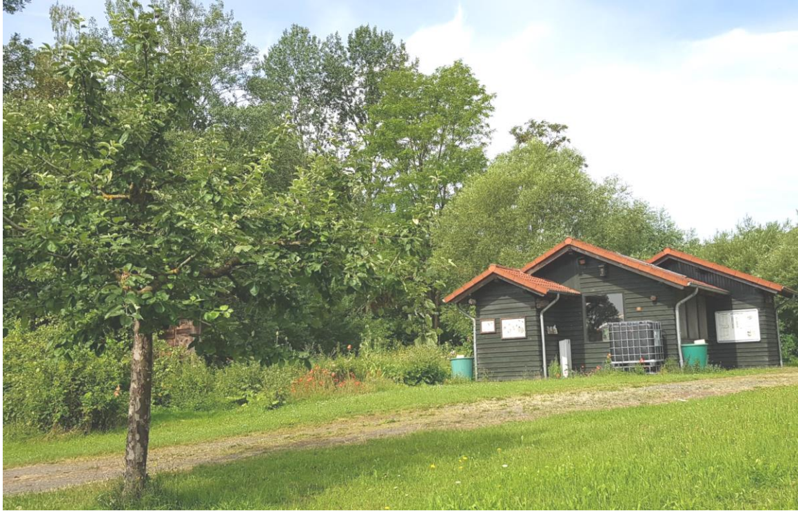
Abb. 23 Hummelwerkstatt. Links davon naturbelassene Anpflanzung von Blütenpflanzen. Im Vordergrund ein Apfelbaum – zugehörig zu einer Plantage in diesem Gelände.
